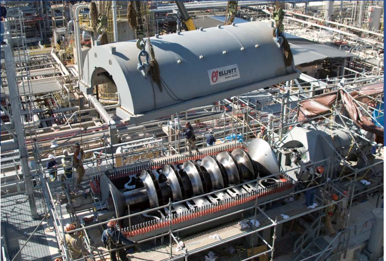
プロピレンプラント向け世界最大級コンプレッサ(エリオット社製)の据え付け
