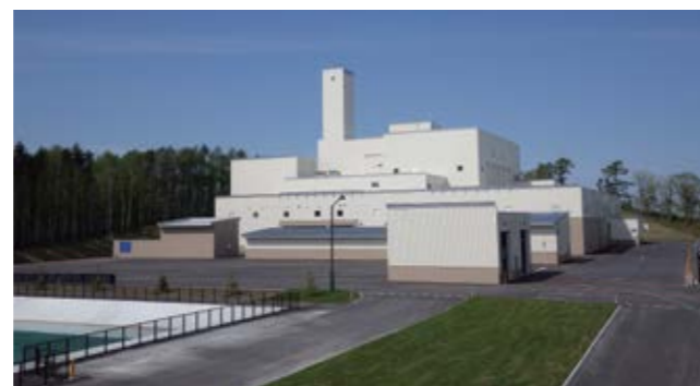
岩見沢市向けごみ焼却施設(いわみざわ環境クリーンプラザ)
