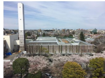
発電設備を有するごみ焼却施設 (武蔵野クリーンセンター)
