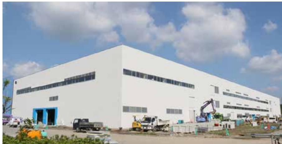
現在の工事の様子（2016年10月18日撮影）
