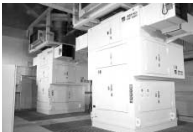
写真3 立形ガスタービン Photo 3 Vertical gas turbine-engine
