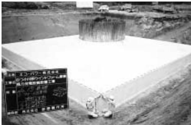
写真2 コンクリート基礎工事写真 Photo 2 A concrete foundation under construction
