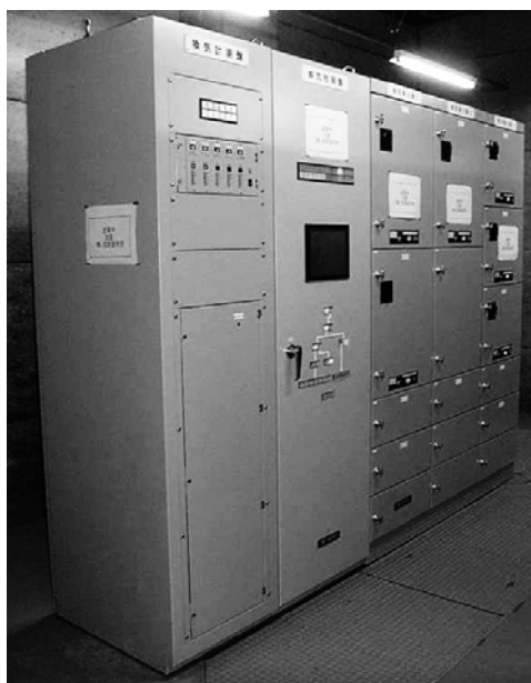
写真39 換気制御盤及び計測盤
