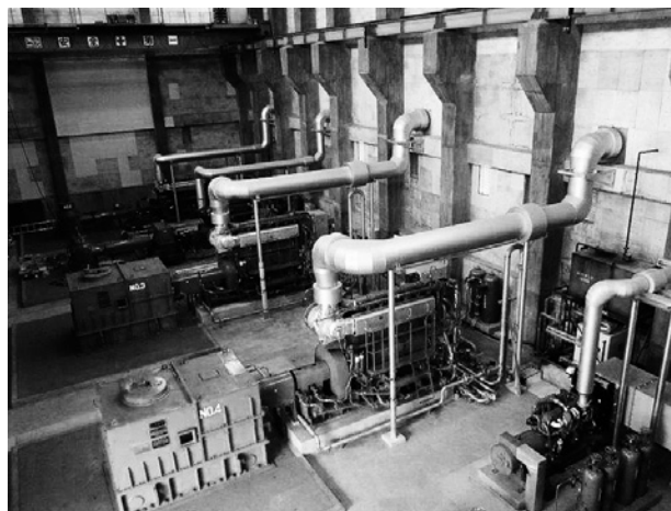
写真31 原動機室全景（立軸斜流ポンプ×4台）
