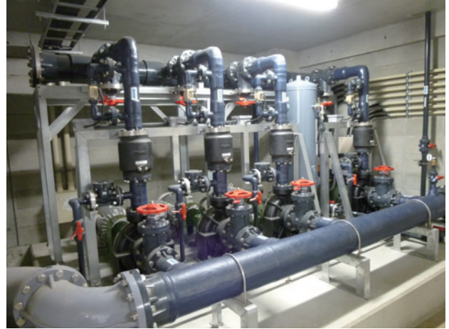
写真6 流し込み型ポンプユニット USWN型 Photo 6 View of the positive suction pressure pump unit model USWN
