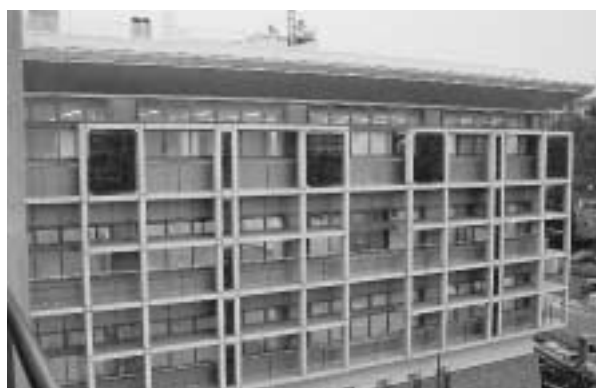
写真48 建材一体型ライトスルータイプ太陽電池モジュール Photo 48 Light-through type, solar module integrated into building
