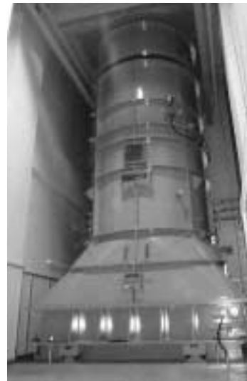
写真17 トンネル換気用軸流排風機 Photo 17 Axial type tunnel exhaust fan
