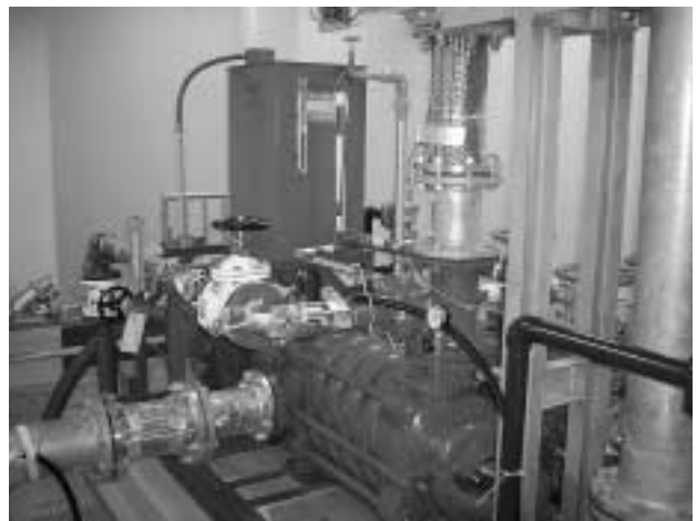
写真21 消火ポンプ設備 Photo 21 Fire pump facility
