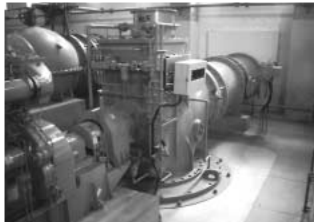
写真15 No. 5ポンプ (口径1200 mm) Photo 15 No. 5 drainage pump ( \phi 1200 mm)
