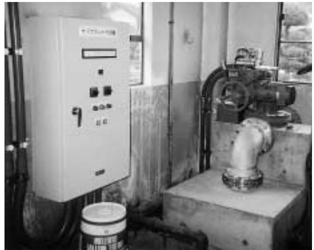
写真3 電動急開・緩閉ロート弁 Photo 3 Electric quick-open/slow-closing conical plug valve
