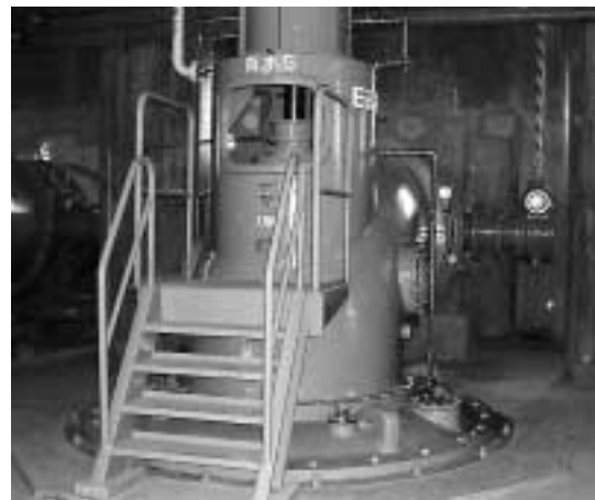
写真14 堀切ポンプ所雨水ポンプ (口径1500 mm) Photo 14 Rain water pump ( \phi 1500) of the Horikiri Pumping Station
