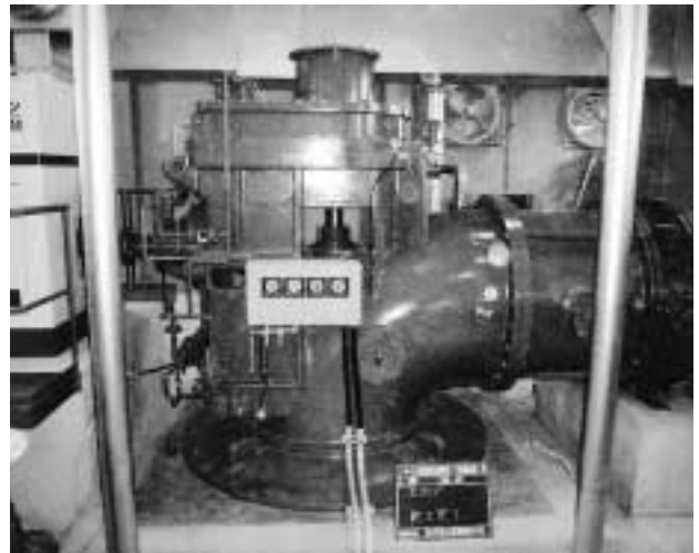
写真10 鯉田排水機場No.3ポンプ（口径1350 mm） Photo 10 Main pump (φ 1350) of the Namazuda Drainage Pumping Station
