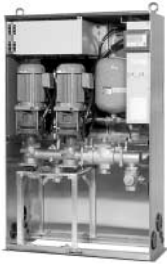
写真6 直結給水ブースタポンプ（ウォールキャビネット形） Photo 6 Packaged booster pump system (Model PNAEM)
