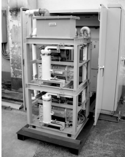
写真1 真空ポンプユニットからフレームを引き出した状態 Photo 1 Vacuum pump with pulled out from frame
