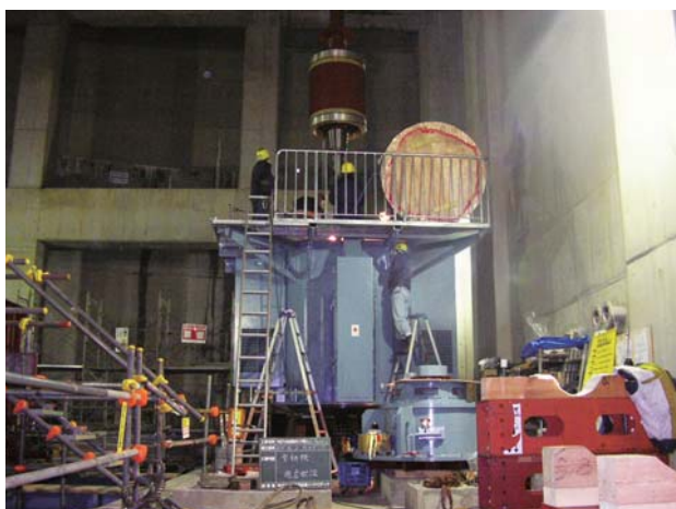
写真7 電動機現地組立 Photo 7 Electric moter site assembly
