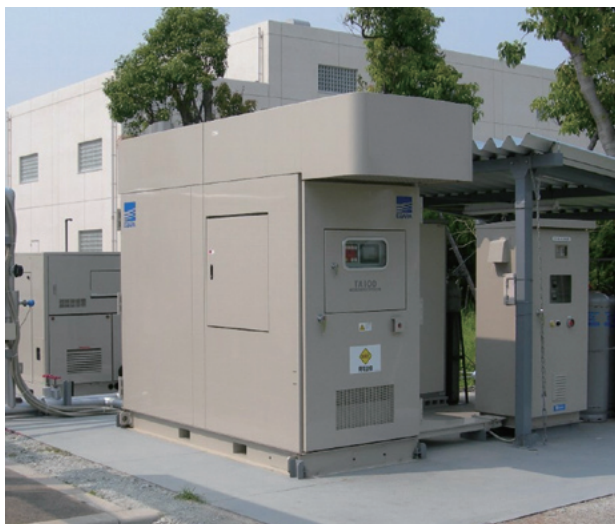
写真2 マイクロガスタービン消化ガスコージェネレーションシステム Photo 2 Microturbine cogeneration system utilizing sewage digester gas
