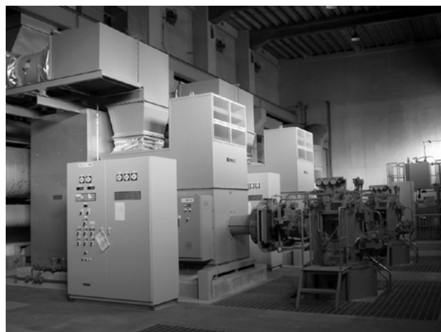
写真26 ポンプ駆動機（ガスタービン及び減速機） Photo 26 Pump driver 735 kW gas turbine & gear
