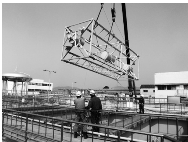
写真56 フロキュレータ据付状況
