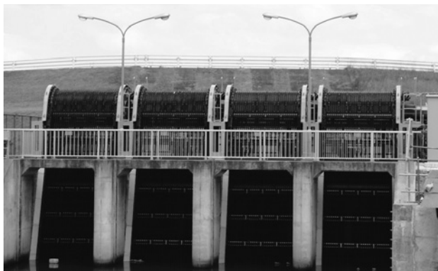
写真32 ペンタム®樹脂製改良型自動除塵機 Photo 32 PENTAM® plastic type automatic trash rakes (improved model)
