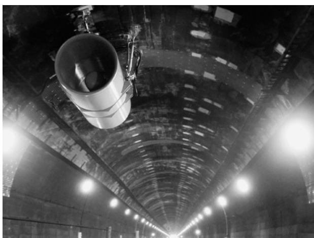
写真40 ジェットファン (JFX-1250 高風速型) Photo 40 Jetfan (JFX-1250 high-velocity)
