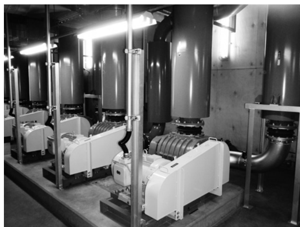
写真55 工事後押込送風機
