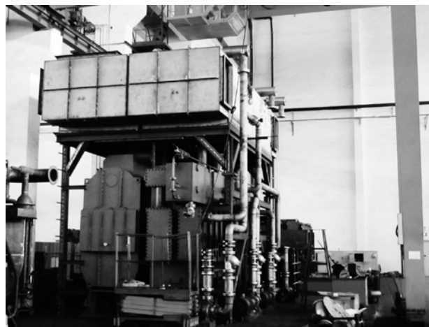
写真49 RHP061D型吸収式ヒートポンプ
