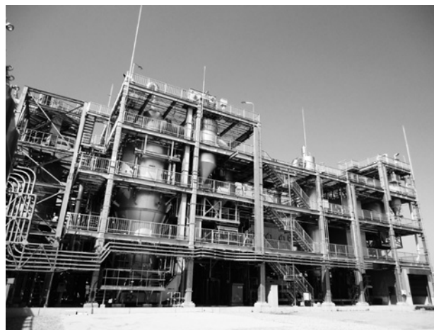
写真59 原田処理場3系汚泥焼却設備
