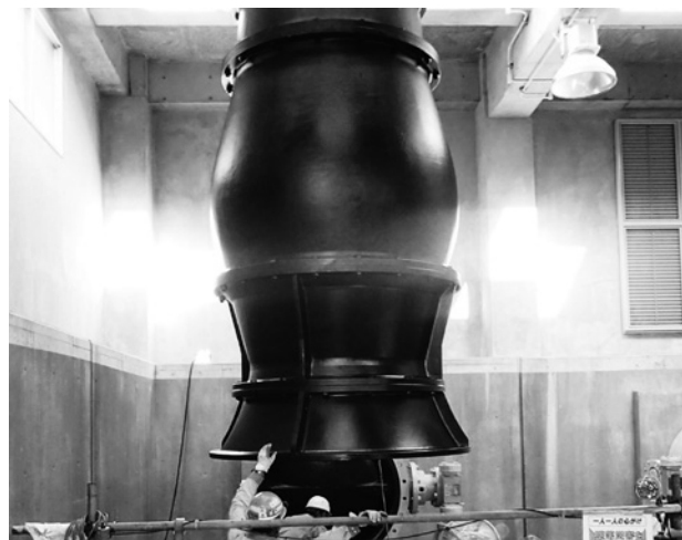
写真34 1350 mm 立軸斜流ポンプ Photo 34 1350 mm vertical mixed flow pump
