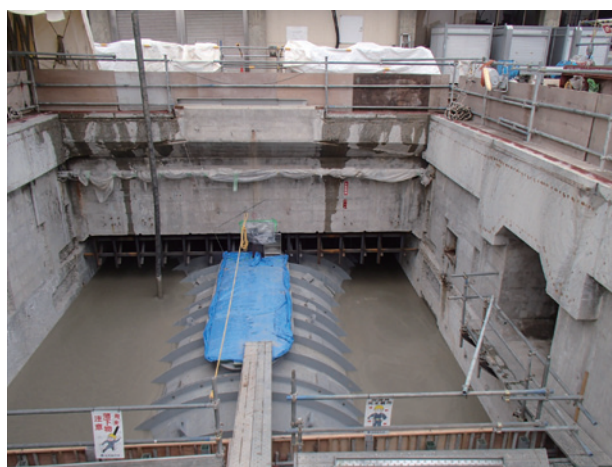
写真4 ポンプケーシングの外観と二次コンクリートの打設中 Photo 4 View of pump casing/secondary concrete placement
