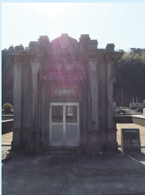
図1 1号濾過池調整井正面
